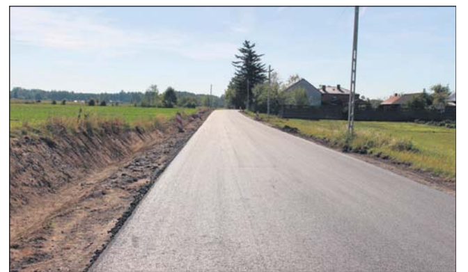
Fragment remontowanej drogi powiatowej 4518W w miejscowości Ostrownica w gminie Kazanów.
